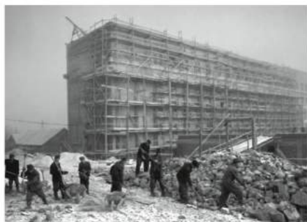
A C épület építése
